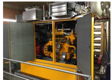
Der Liebherr Gasmotor liefert eine Wellenleistung von 90 kW
