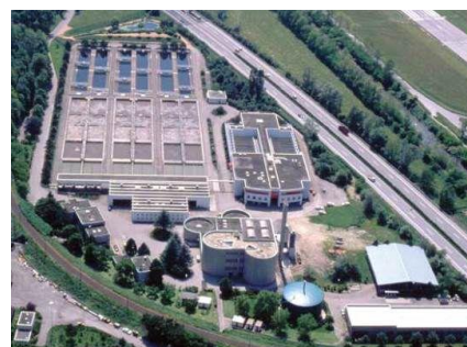
Luftbildaufnahme der ARA Region Lugano in der Gemeinde Bioggio
