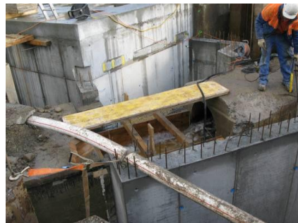
Provisorium im Bereich Abwasserentnahmeschacht auf der ARA-Auslaufleitung
