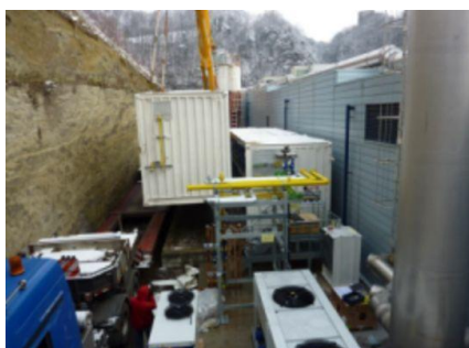
Installation der Container und Aussenkomponenten auf vorbereitete Fundamente
