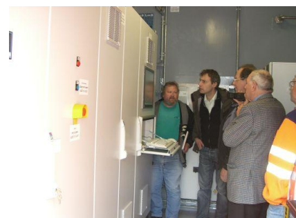
Schulung des Personals im Steuerungsraum des Containers
