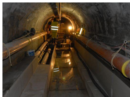
Eingelegte Ploymerbetonelemente mit (noch) offener Verrohrung (Tichelmannsystem)
