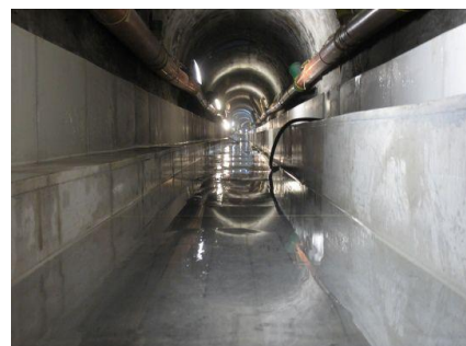
Abgeschlossene Arbeiten: Polymerbetonwärmetauscher im (noch) sauberen Zustand
