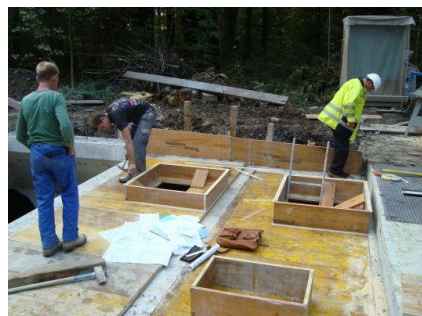
Schalung der neuen Decke über den Einlaufkammern. Die vordere Aussparung ist für die Durchströmturbine
