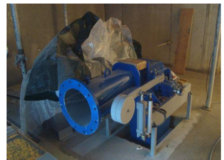
Montage der Durchströmturbine im Rohbau auf einbetonierte Stahlträger. Anschliessend wird das Turbinengestell ausgegossen.
