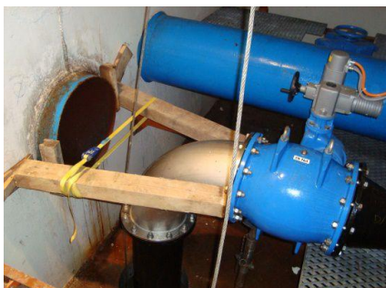
Erstellen des Provisoriums (Verbindung von Zulauf und Ablauf) mit einer Gussleitung sowie Chromstahl-Passstück.
