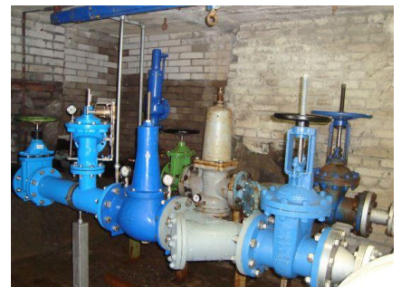
Revidierte Druckreduzierung für die Sprinkleranlage und Betriebswasser ab der Druckleitung
