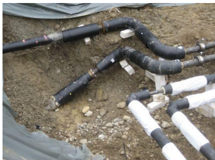
Verbindung von flexiblen und starren Vor- und Rücklaufleitungen
