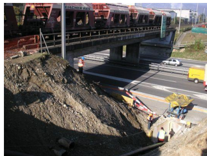
Schlüsselstellen sind Autobahn- und Eisenbahnunterquerungen
