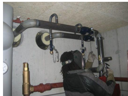
Anschluss der Fernwärmeleitungen an die Wärmeübergabestation in einem Gewerbegebäude
