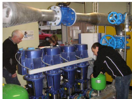
neue Pumpenanlage und Rohrinstallation im Pumpwerk
