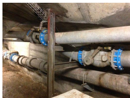
Ausschnitt aus dem Stollen mit den Asbestzementdruckleitungen
