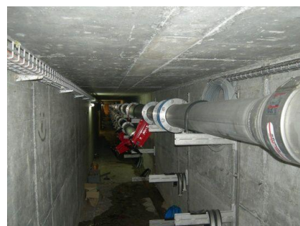
Montage der neuen Druckleitungen in nichtrostendem Stahl
