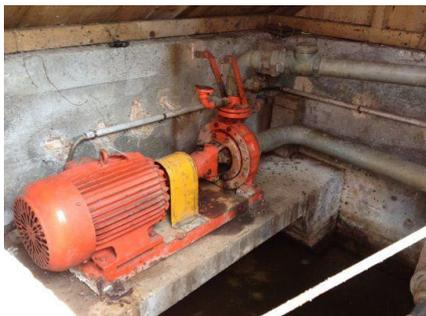
Pumpe, welche das Wasser aus dem nahe gelegenen See zu den Sprinkleranlagen befördert. Sie bleibt für Notfallsituationen in Betrieb.
