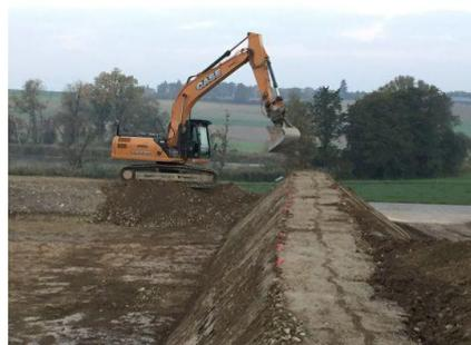
Aufschüttung des Damms an der N-W Kante. Der Gehängelehm des Aushubmaterials ist dafür nicht geeignet. Gut verdichteter siltiger Kiessand wurde für den homogenen Schüttdamm von auswärts bezogen.
