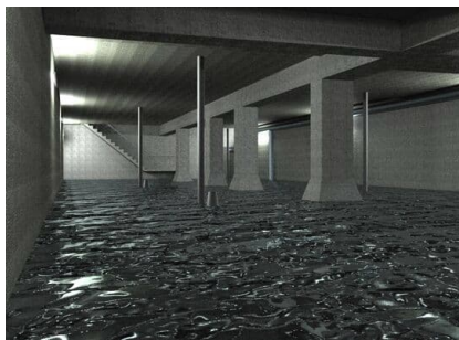
Visualisierung Rückhaltebecken mit Air-Jets
