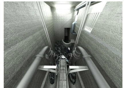
Visualisierung Transportleitungen auf kombinierter Absturzsicherung / Haltekonstruktion montiert
