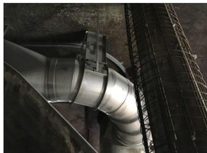
Bypass: Als Sicherheitsmassnahme wird das Regenrückhaltebecken während den Bauarbeiten ausser Betrieb genommen - Rechts: Stützenarmierung
