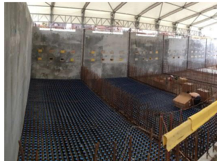
Erstellung Düsenboden Filtration
