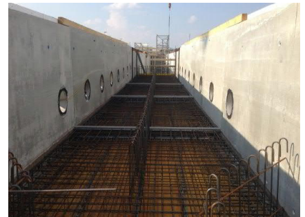
Armierung Ablaufkanal Absetzbecken
