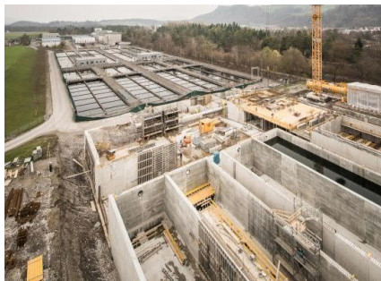
Blick auf die bestehende Anlage
