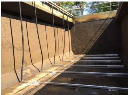
Vorbereitung der Membranplattenträger
