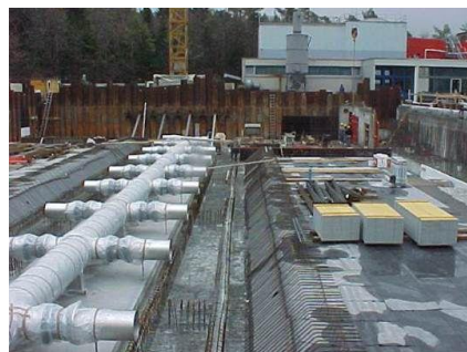
Rohrleitungsinstallationen im Rohbau
