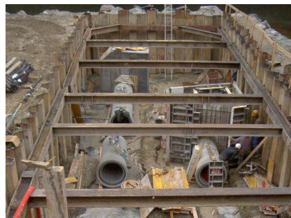
Rohrleitungsbau in der Baugrubenumschliessung
