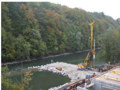
Vorbohrungen für Baugrubenumschliessung
