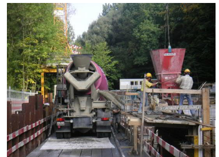
Hilfsbrücke durch Baugrube
