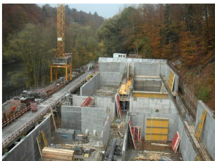
Bodenplatten Strasse 1 und 2 sowie Mitteltrakt
