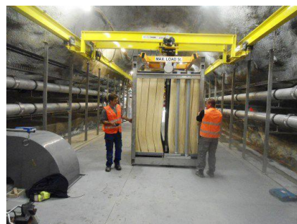
Membrankassette auf dem Weg zum Einbau
