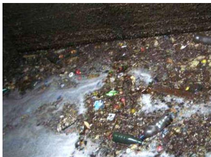
Schwimmstoffe im bestehenden Ölabscheider Halenbrücke
