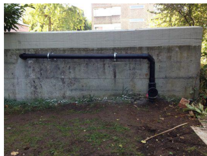
Dachabwasser Garage Westseite gefasst
