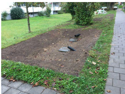
Vor Fertigstellung (Platten werden durch Bollensteine ersetzt, Einläufe noch verkürzt)
