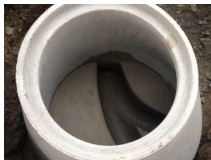
Von Hand erstelltes Schachtbankett
