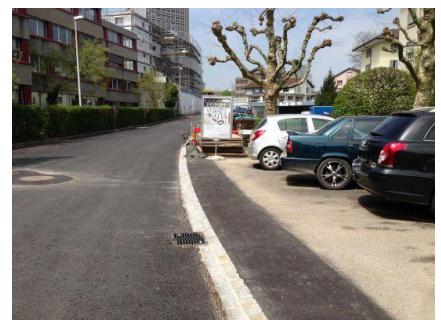
Nach Einbau der Belagstragschicht
