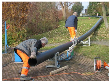
Vorbereitung des Mediumrohres für den Einzug
