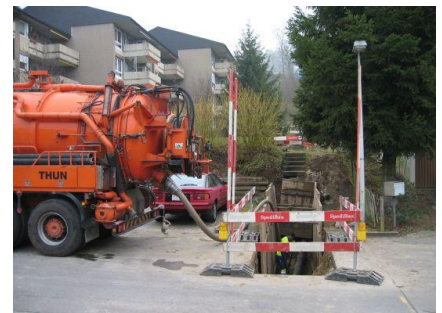
Absaugen der Stützflüssigkeit nach dem Einzug des HDPE-Rohres
