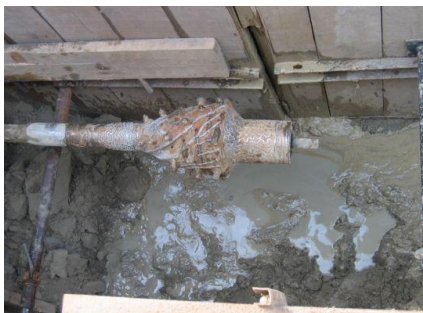
Wechsel des Bohrkopfes (Ausweitungsbohrung)
