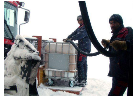
Leerung Fettabscheider Morenia über Zapfpistole in Rollcontainer
