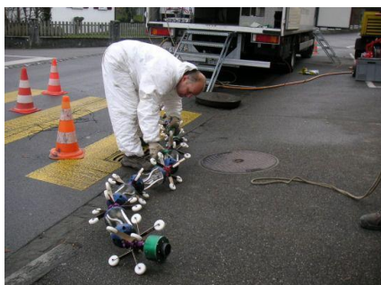
Vorbereitung der UV-Lichterkette für die Aushärtung des Berolina-Liners.
