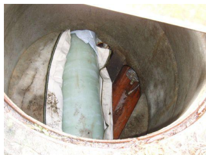
Der Liner wurde über zwei Haltungen durch diesen Kontrollschacht durchgezogen und nach der Aushärtung geöffnet. Rechts im Bild zu sehen, wie der seitliche Zufluss mit einer Absperrblase verschlossen ist.
