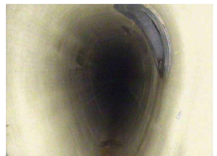
Ei-Profil 450/300 nach der Inlinersanierung, rechts oben ein seitlicher Einlauf, kraftschlüssig eingebunden
