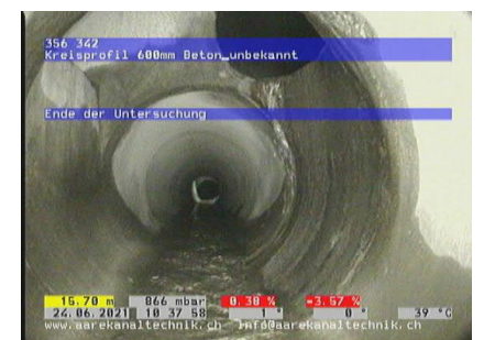
Einblick in die Kanal-TV Aufnahmen
