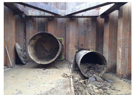
Bahnunterquerung mittels Schlagvortrieb
