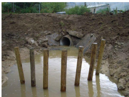
Feststoffrückhalt, neuer Sandfang und Terrainanpassungen, Juli 2007 (1)
