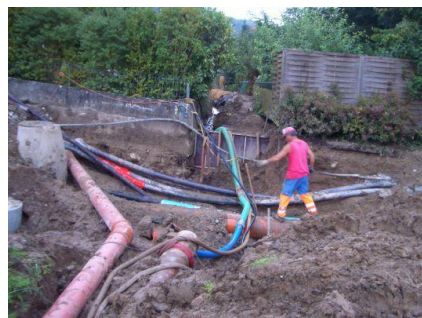
Aufweitung, Revitalisierung und Vergrösserung Durchlass (neues Wellstahlrohr), Sept. - Okt. 2007 (2)
