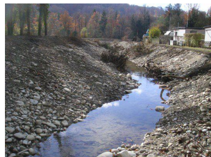
Bachumlegung, neue naturnahe Gestaltung, Durchlass Forstweg + Mündung in Sense, Okt. - Nov. 2007 (3)
