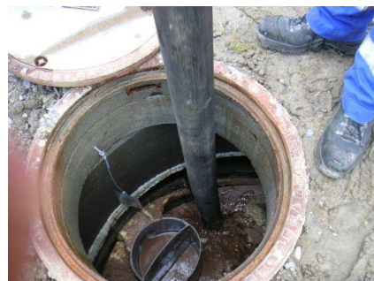
"Fettdeckel" muss mechanisch zerschlagen werden, um ihn fliessfähig zu machen
