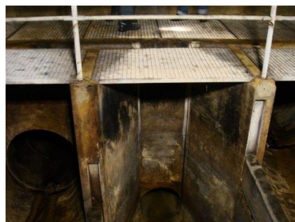
Zustandsbeurteilung der Sonderbauwerke: Aare-Düker in Solothurn
