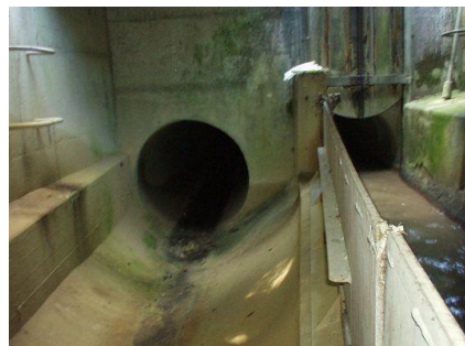
Zustandsbeurteilung der Sonderbauwerke: HE Senseried
